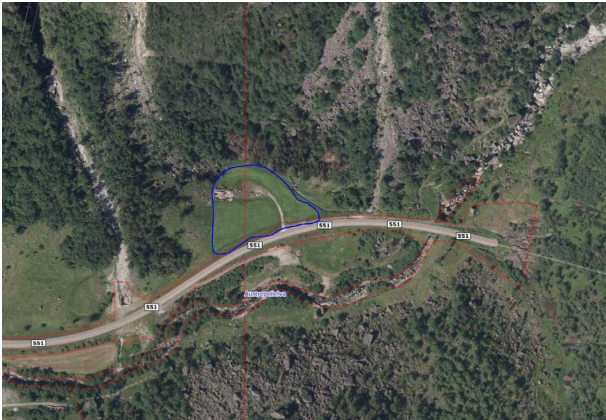
Mogleg deponiområde ved Folgefonntunnelen
