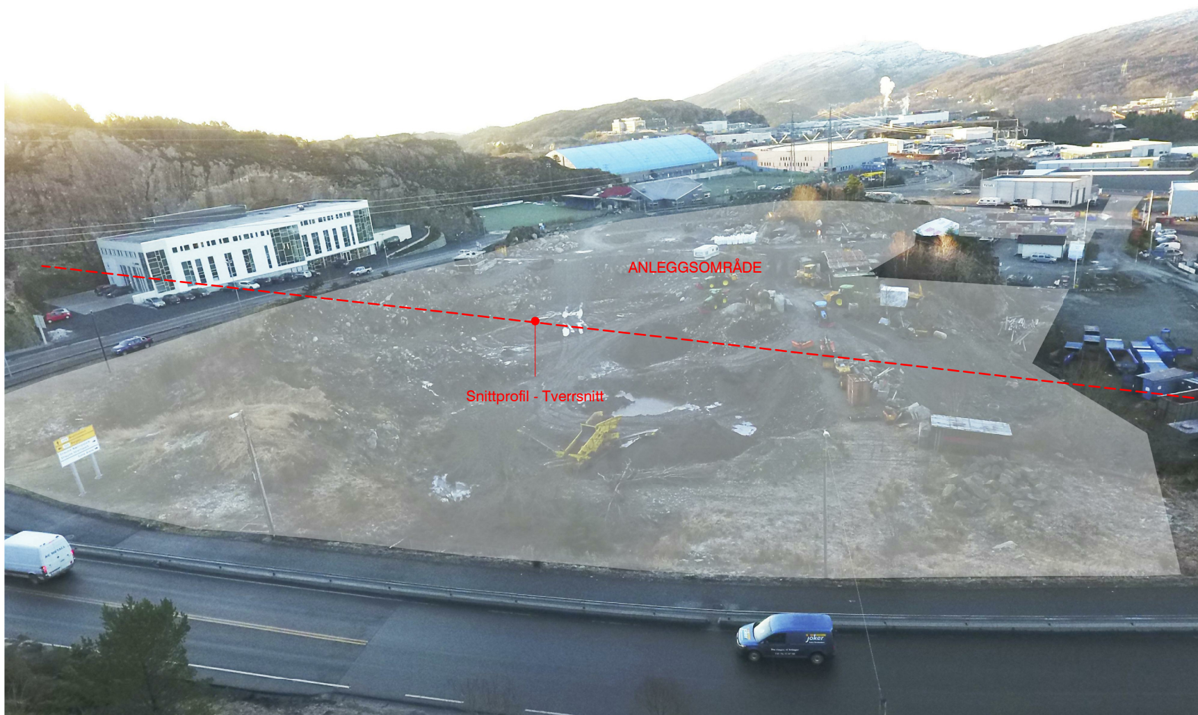
OVERSIKTSBILDE EKSISTERENDE OMRÅDE
