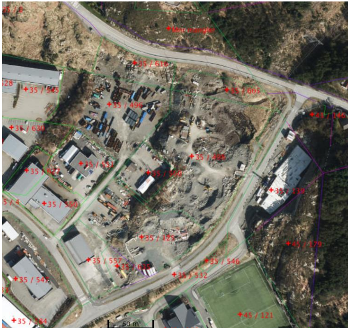
Figur 7-16 Eksisterende areal før utbygging.
