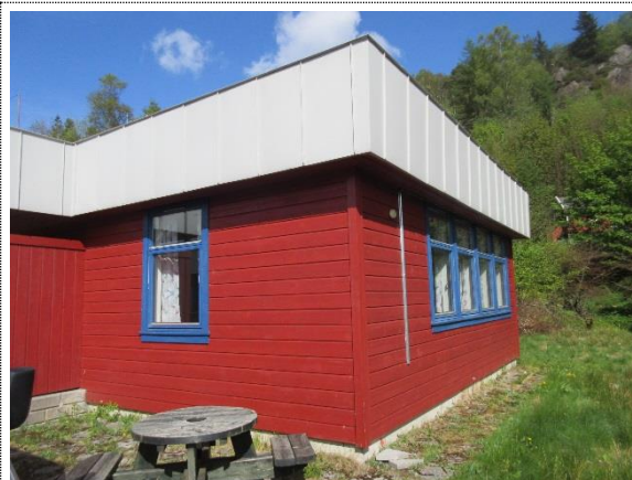
Bilde nr. 2 Bygget står på en isolert betongsåle. Ytterveggene er kledd med liggende trepanel.
