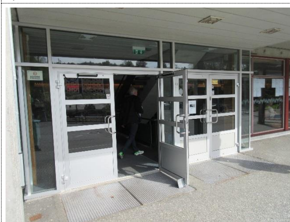
Bilde nr. 10 Hovedinngangsdører i eloksert aluminium, trolig fra 1990-tallet.
