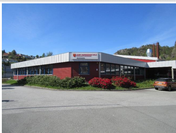
Bilde nr. 1 Verkstedbygget sett fra sør.
