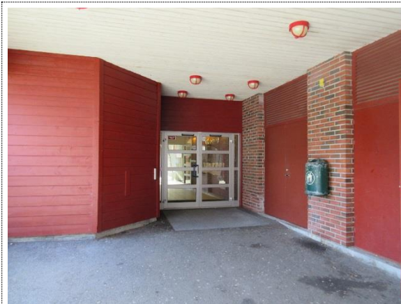
Bilde nr. 2 Hovedinngang vis à vis Hovedbygget.
