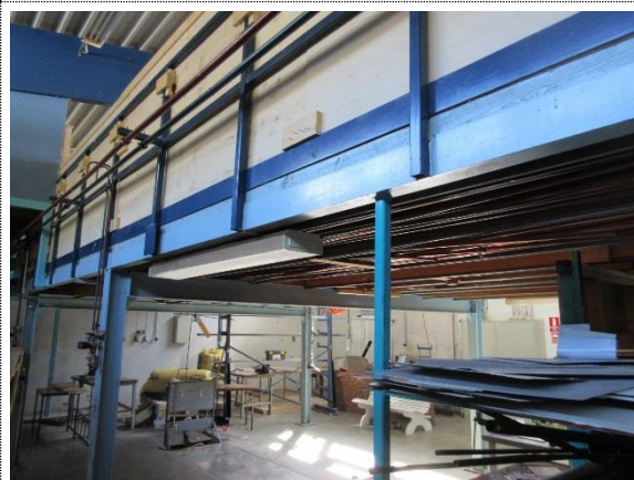
Bilde nr. 18 Mezzaninetasje med bæring i tre.
