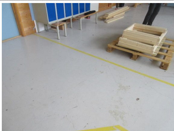
Bilde nr. 17 Byggfag-hallen med malt betonggulv.
