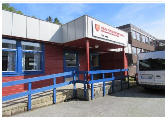
Bilde nr. 3 Rampe opp til inngangsdørene.
