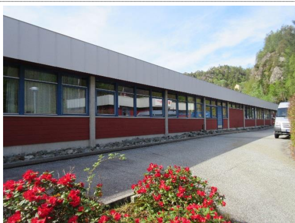
Bilde nr. 3 Østfasade – bygget står på ringmur/betongsåle.
