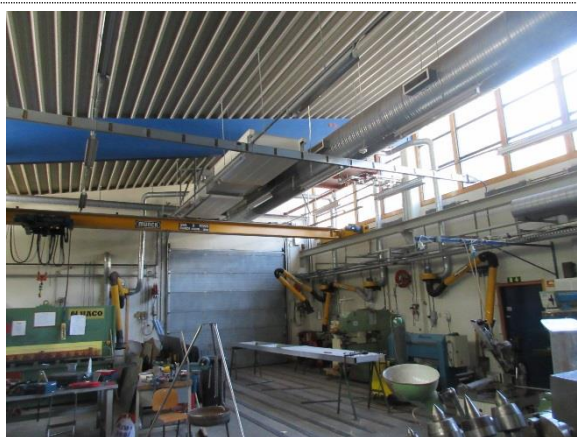
Bilde nr. 13 Verksted med traverskran.
