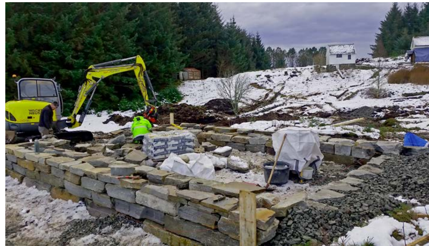
Grøfting og drenering, og grunnarbeid for nytt grillhus i Skaganeset friluftsområde på Radøy.
