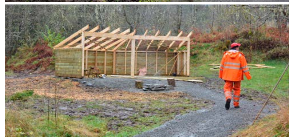
Espen bygger ny gapahuk i Fisketangen friluftsområde i Lindås kommune. Foto: BOF.
