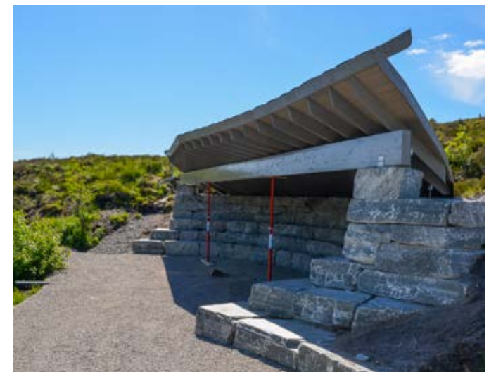
Ny gapahuk i Kårtveitpollen friluftsområde i Fjell.
