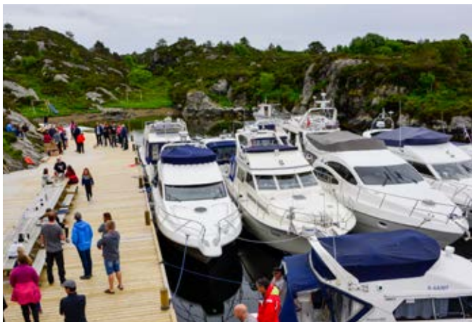
Ankerjengen båtlag gjorde ferdig kaianlegget i Nordre Navøyvågen.
