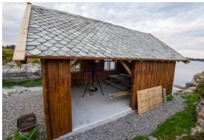
Bygdelaaget DRØ-Vel gjorde ferdig nytt grindabygg i Øksnes friluftsområde i Austrheim kommune.
