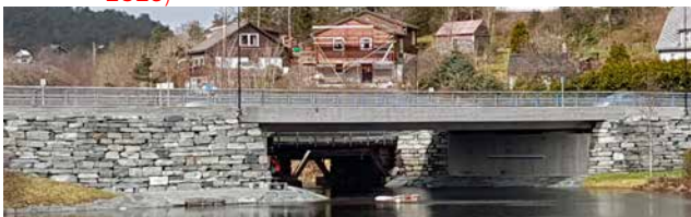
Sagvåg bru før og etter
