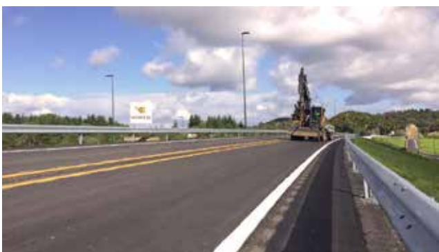
Vegopning Stokkabekken - Siggjavåg
