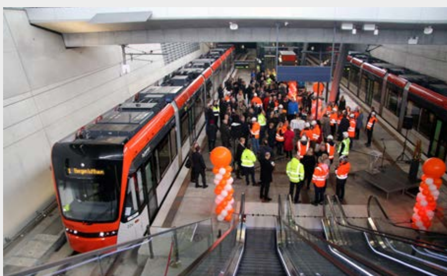
Åpningen av den nye bybaneterminalen på Flesland 21. april 2017 markerte ferdigstillelsen av Bybanens byggetrinn 3. Foto: Ingrid Feet Bjørge, Statens vegvesen
