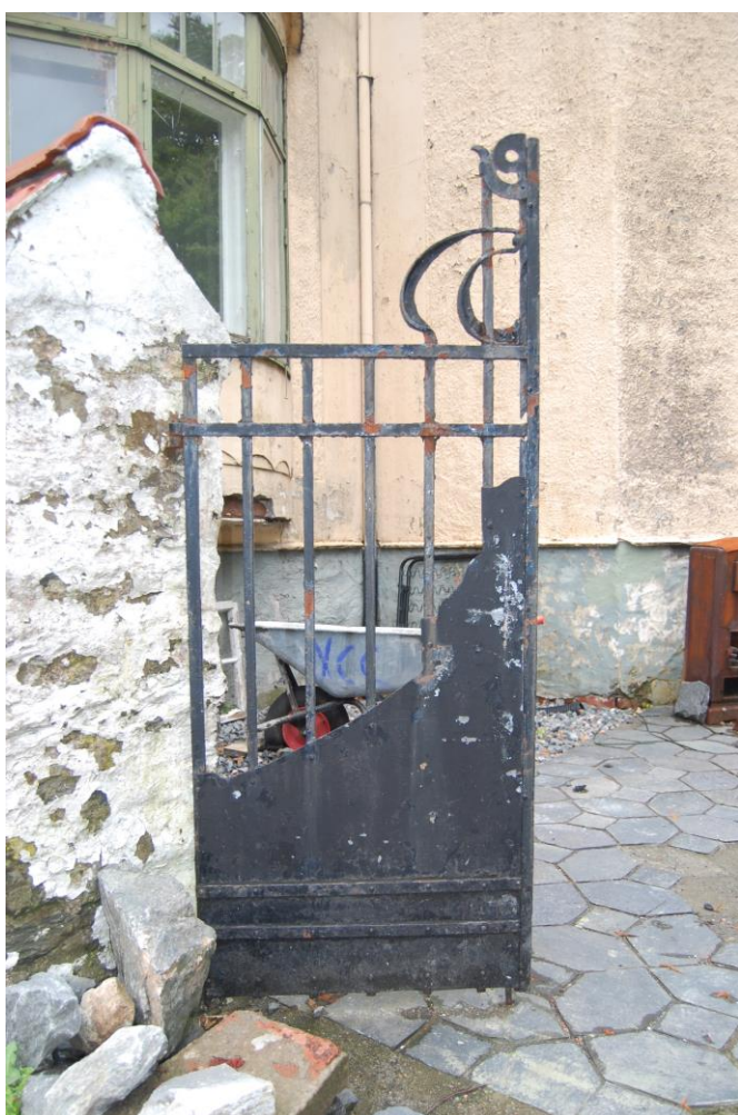
Det eine portbladet til den opphavlege porten til gardsplassen
