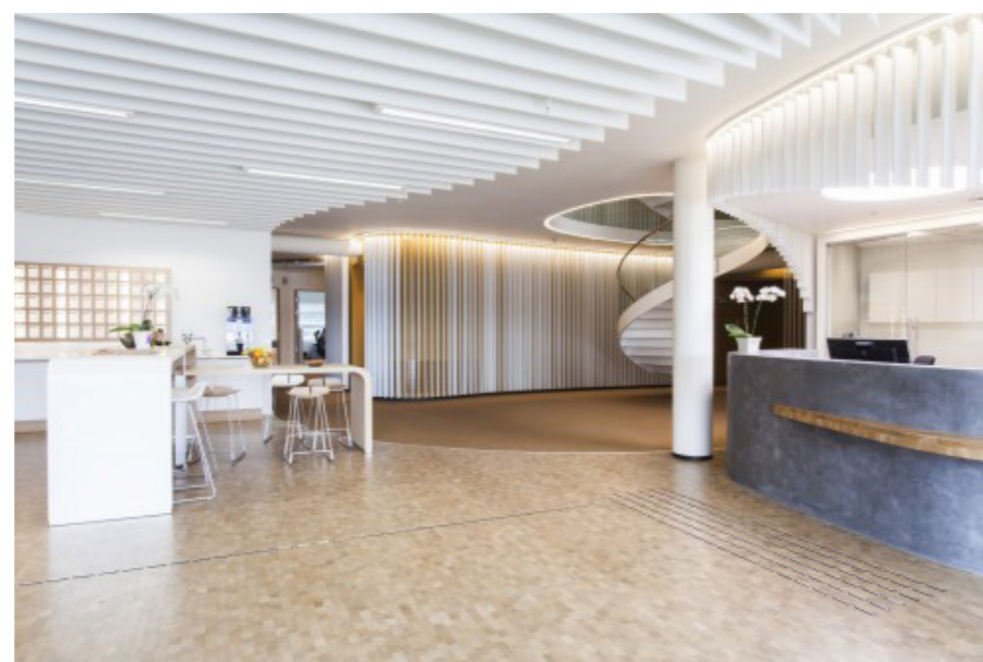
Akustiske baffler. Powerhouse Kjørbo kontorer i Bærum. Arkitekt: Snøhetta.
