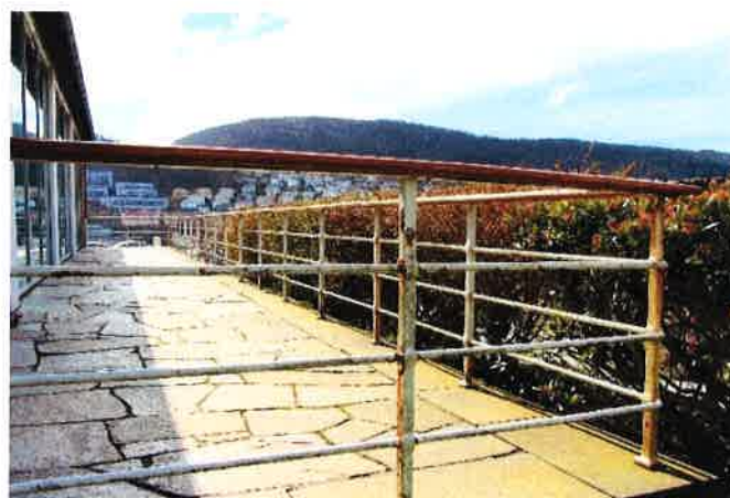
Rekkverk terrasse nord
