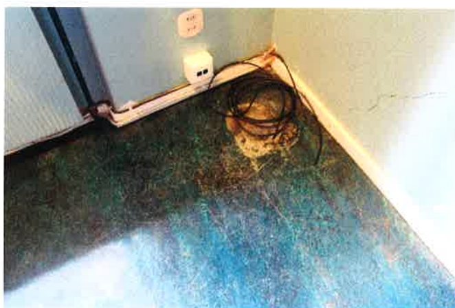
Sprekk i skillevegg rom 204
