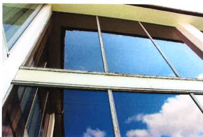
Mlingslitte vinduer i gårdsrom
