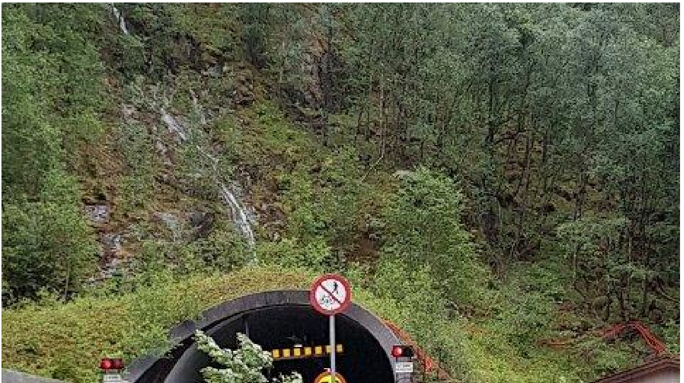
Stengt på grunn av ras: E39 åpner ikke i dag
