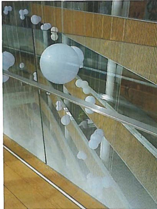
Figur 44 Glassrekkverk med innlagt raster (foto:L.Aasness)
