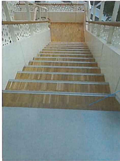
Figur 40 Kontrastmarkering av trappetrinn (foto:L.Aasness)
