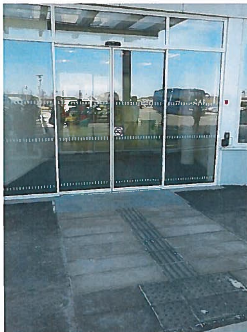
Figur 9 Ledelinje sentrert i tofløyet inngangsparti (foto:L.Aasness)
