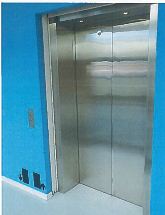
Figur 46 Heisdør med brannskille og tilkallingsknapper (foto:L.Aasness)
