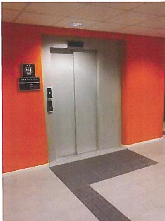
Figur 47 Heisdør med farefelt foran (foto:L.Aasness)
