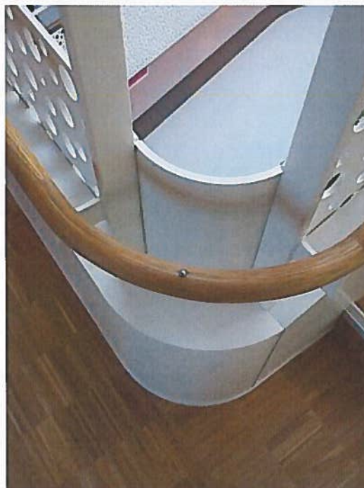
Figur 28 Liten nagle på håndlist markerer etasje (foto:L.Aasness)
