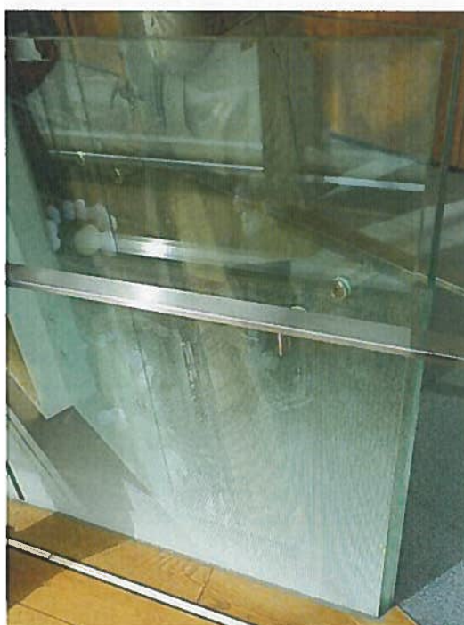
Figur 43 Glassrekkverk med innlagt raster (foto:L.Aasness)
