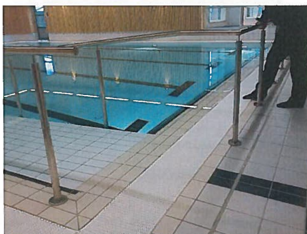
Figur 26 Rekkverk og ledelinje leder mot rampe ned i vannet (foto:L.Aasness)
