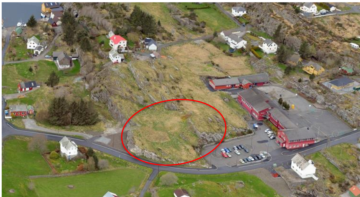
Figur 13. Skråfoto av område avsett til utviding av Rong barneskule, tatt mot nordvest
