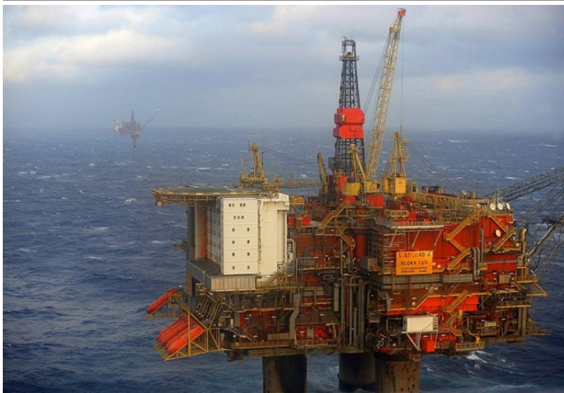
Figur 2-9 Statfjord A-plattformen, dekkсанlegget
