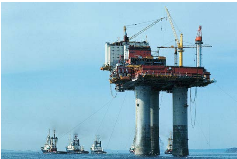
Figur 2-10 Statfjord A-plattformen med dekkсанlegg under uttauing i 1977
